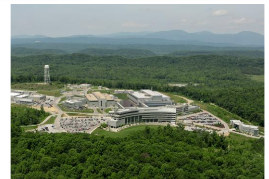
STS shown on SNS site
